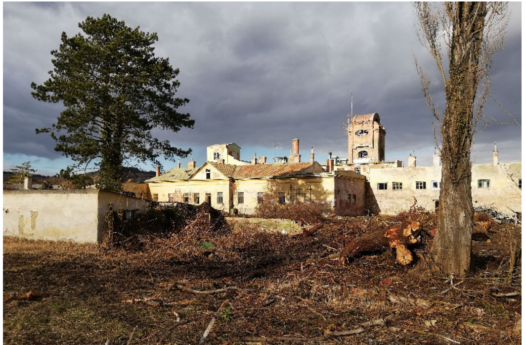
Das Areal im Februar 2022 während der ersten Entkernungs- und Rodungsarbeiten.
