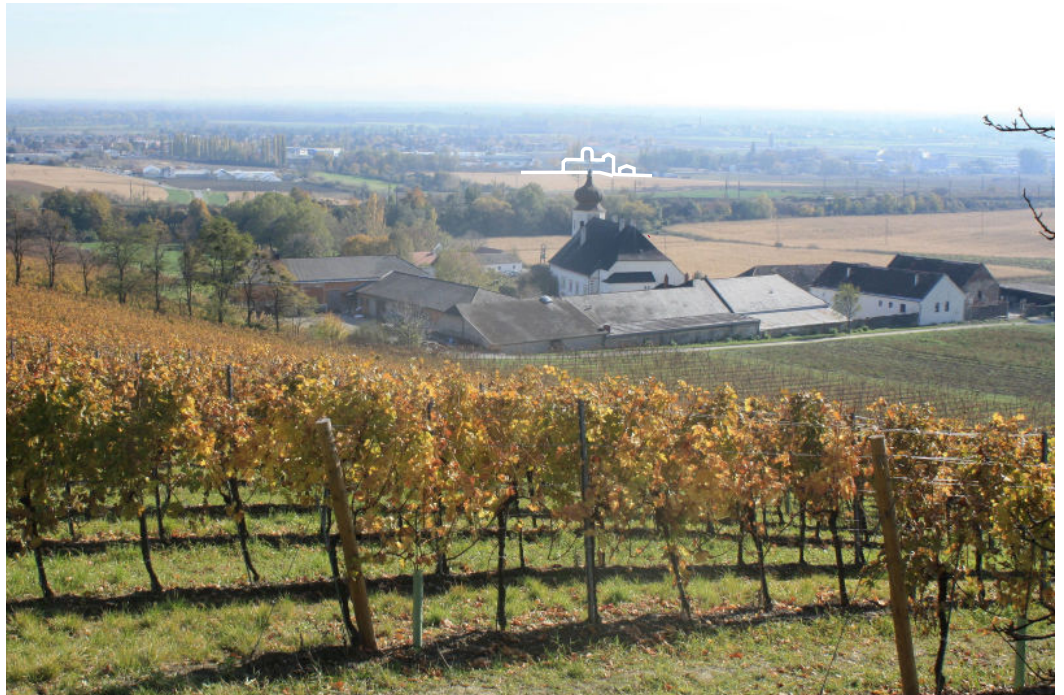
Das Weingut Thallern und das Walzwerk (hier im Hintergrund) liegen idyllisch zwischen den Weinbergen der Thermenregion
